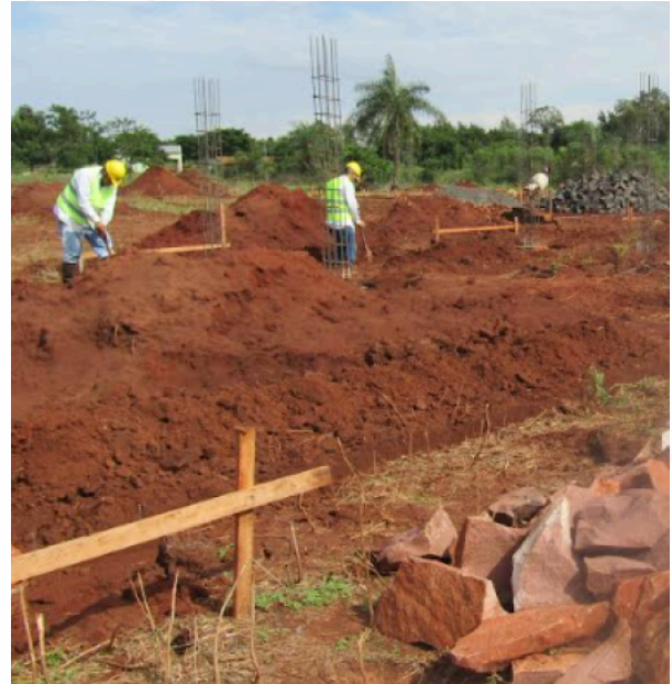
Inicio de Obras UNAMIS Sede Santa Rosa
